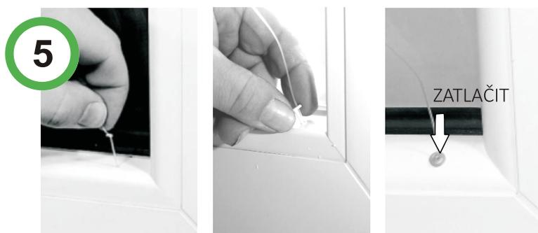
Na konci vodící struny uděláme uzlík (na struně zůstane fixační kolík). Strunu vsuneme do díry a zajistíme fixačním kolíkem, kolík zatlačíme až na doraz. Nakonec strunu jemně povytáhneme.
