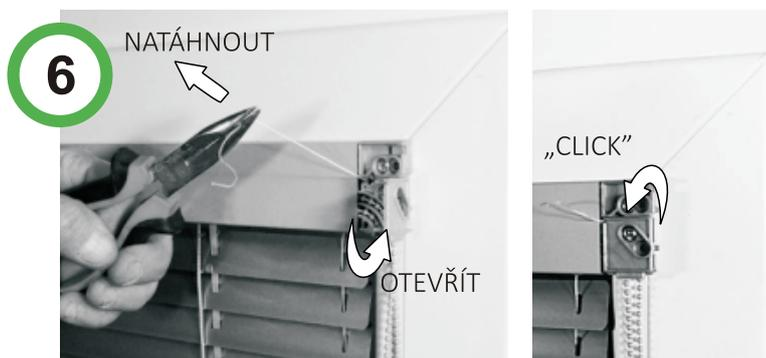
Otevřeme fixační destičku na konci horního profilu, napneme strunu (ne velkou silou), můžeme použít kombinačky. Poté destičku zavřeme a tím zajistíme strunu. Přebytečnou strunu ustříhneme (necháme kousek asi 3 cm).
