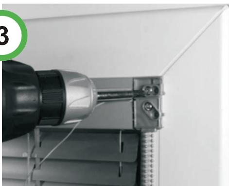
Žaluzii přiložíme na okno. Ujistíme se, že je horní lišta žaluzie pevně usazena k horní zasklívací liště okna.
